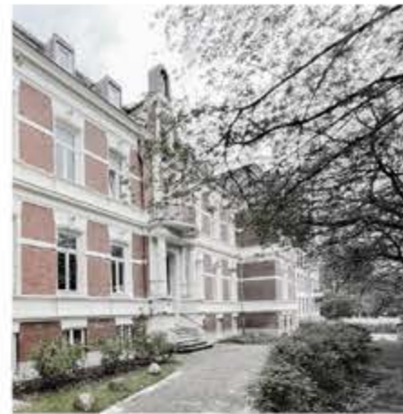
Blick auf den Eingang [2]
